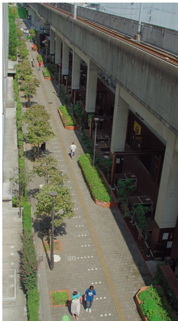
高架下脇に設置された全長130mのアートサイン
